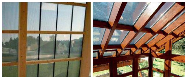
Abbildung 11.12: Einbaubeispiele von Schott-Solar-Panels in Fassade und Sonnendach
