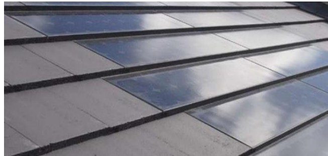
Abbildung 11.7: Ansicht eines Daches mit Solar-Century-Dachziegeln
