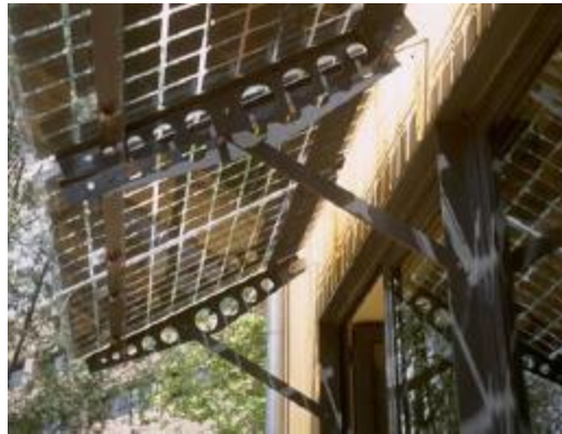
Abbildung 11.14: Befestigung der Module mit Bohrungen in Bereichen ohne Solarzellen
