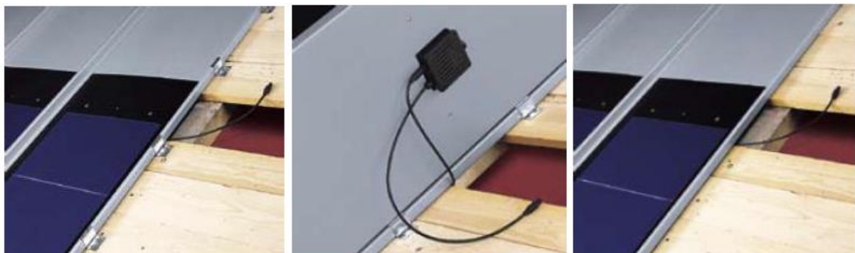
Abbildung 11.4 Installation von Rheinzink-Panels (gemäß der Herstellerdokumentation)
