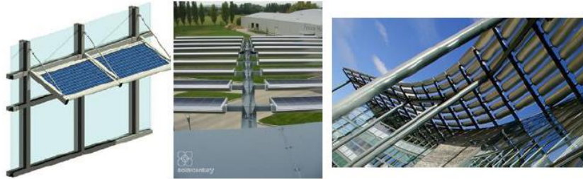
Abbildung 11.13: Beispiel von Tragstruktur und Sonnenblende
