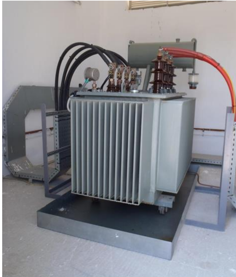
Abbildung 11 - Mittelspannungstrafo
