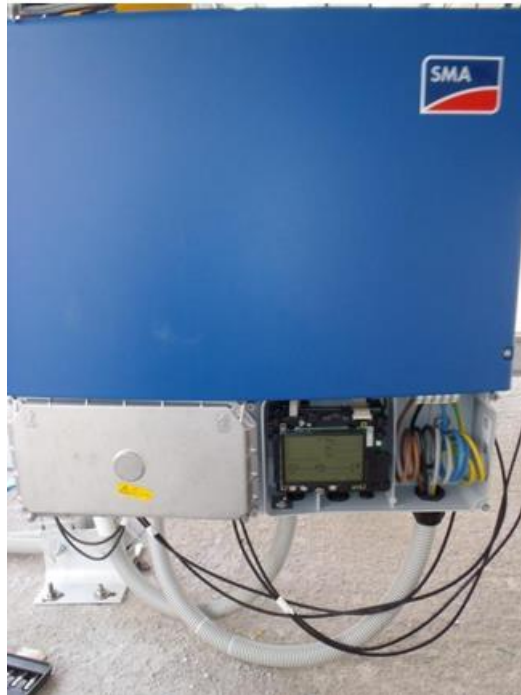
Abbildung 8 – Überprüfung aller Anschlüsse am Wechselrichter
