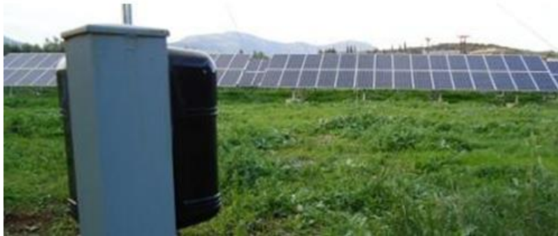
Abbildung 13 - Sicherheitsalarmsensor
