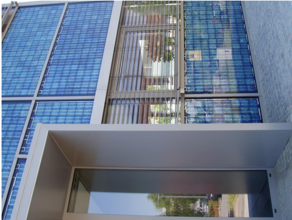
Abbildung 5 - Polykristalline Solarpanels, die nachgerüstet wurden, um die Fassade eines Gewerbegebäudes zu bedecken. Es wurden damit Spiegel ersetzt.
