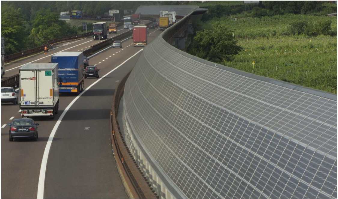
Abbildung 2 - Mittelgroße Solarstromanlage als Schallschutzmauer an einer Autobahn. Brenner-Autobahn, bei Marano, Italien.
