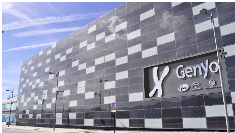
Abbildung 4 - Die von Onyx Solar konzipierte belüftete Solarfassade des Center for Genomic and Oncologic Research (GENyO) der Pfizer-Universität Granada-Junta de Andalucía. Sie erzeugt ungefähr 32 MWh/Jahr.
