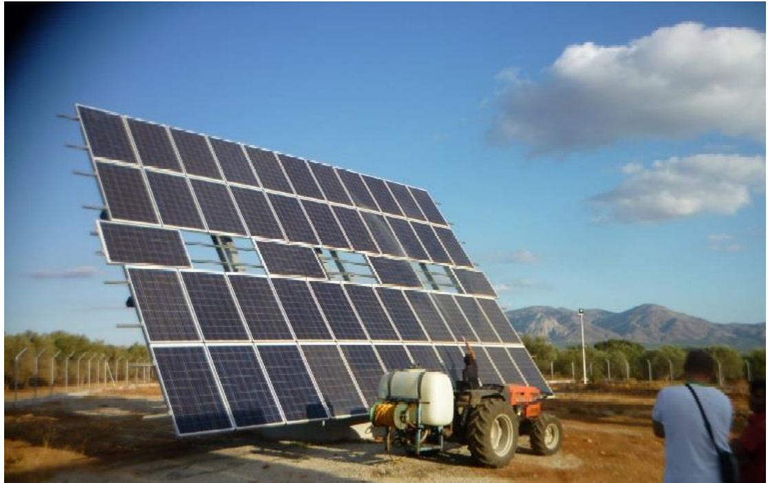
Abbildung 3 - Reinigung einer kleineren Solarstromanlage mittels Wasserstrahl.
