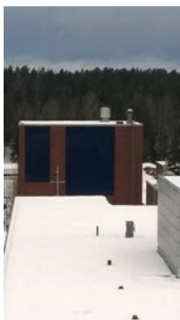
Figura 6.1 fachada fotovoltaica, Universidad Tecnológica de Lappeenranta, Finlandia (cortesía H.BOILEAU)
