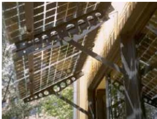
Figura 6.1.2: Fijación de los módulos por perforaciones en zonas sin celular
