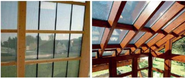
Figura 6.3.2: Ejemplo de integración de fachada y cubierta de paneles semitransparentes Schott-
