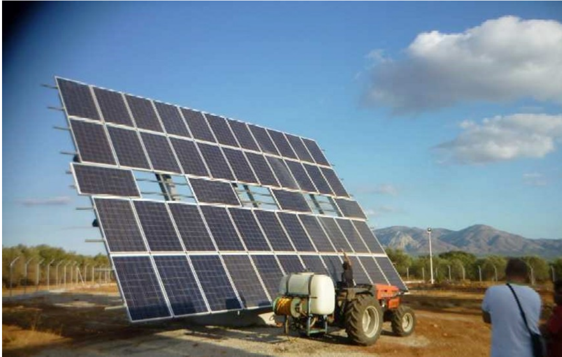
Figura 3 - limpieza de una instalación PV en pequeña escala por chorro de agua.
