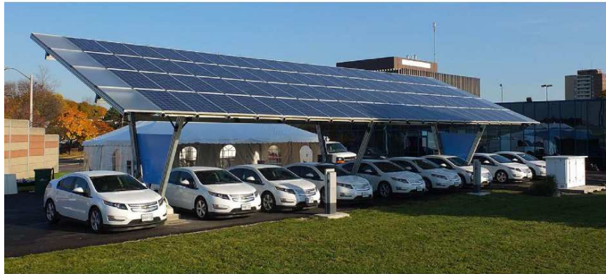
Figure 16 : Véhicules électriques à la station de charge PV faisant également office d'ombrière
