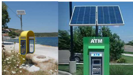
Figure 21 : Cabine téléphonique et distributeur de billets actionnées par PV.
