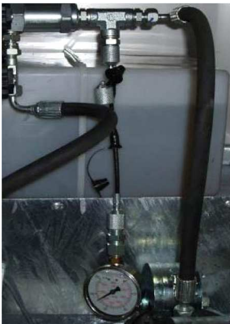
Figure 6 - Contrôle des tuyaux hydrauliques et de la pression du traqueur
