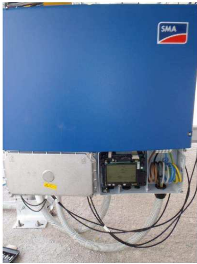
Figure 8 - Contrôle de toutes les connexions d'onduleur
