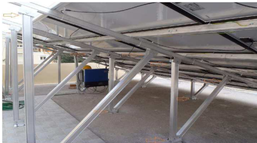
Figure 5 - Contrôle de tous les supports du panneau
