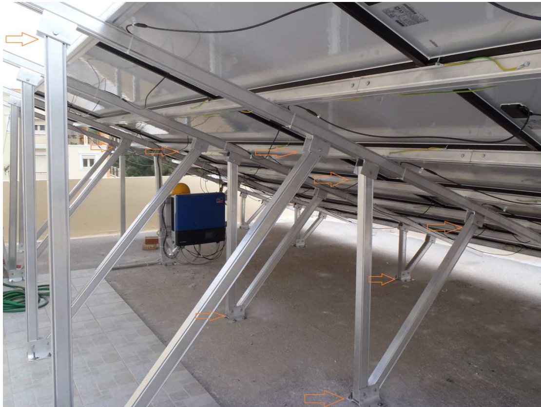
Εικόνα: Έλεγχος σύσφιξης όλων των κοχλιοσυνδέσεων τον Φ/Β σταθμού
