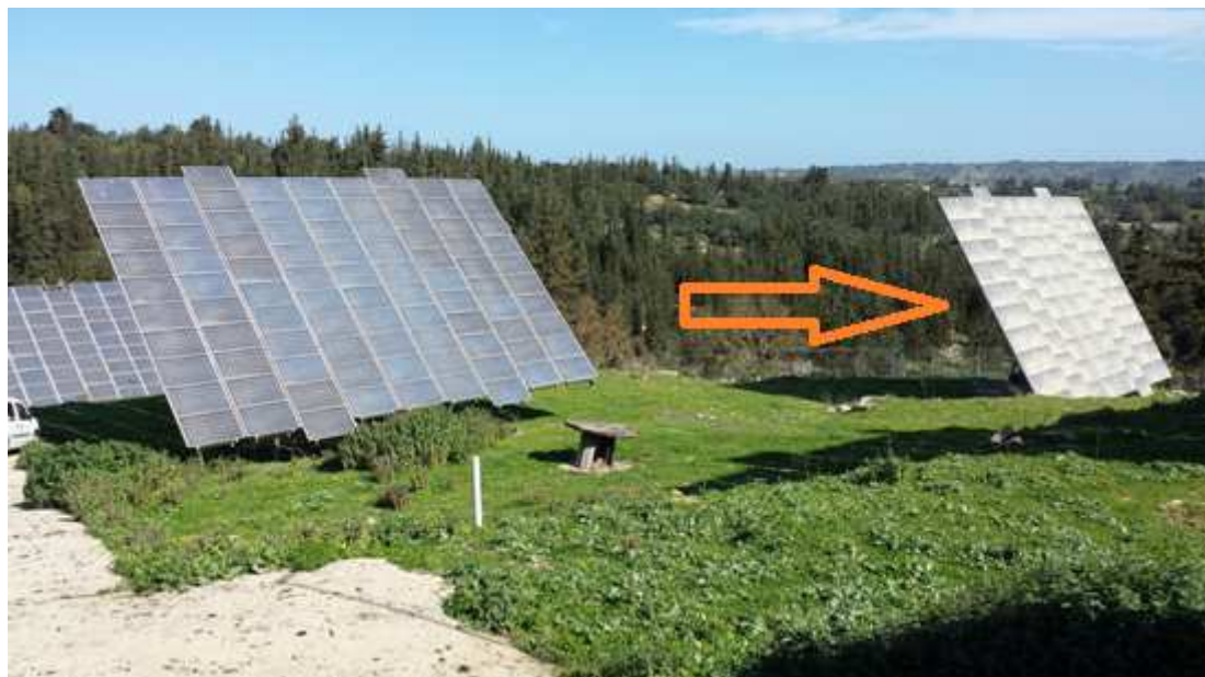
Εικόνα: Έντονη βρωμιά σε ένα tracker από σκόνη
