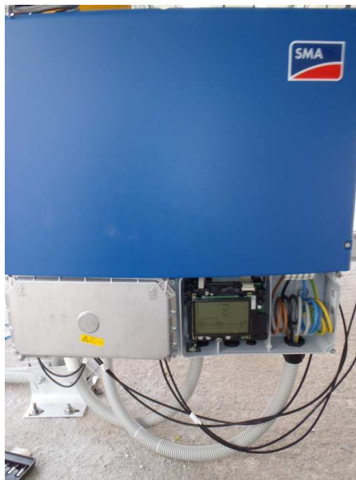
Εικόνα: Έλεγχος όλων των συνδέσεων και για ζημιές
