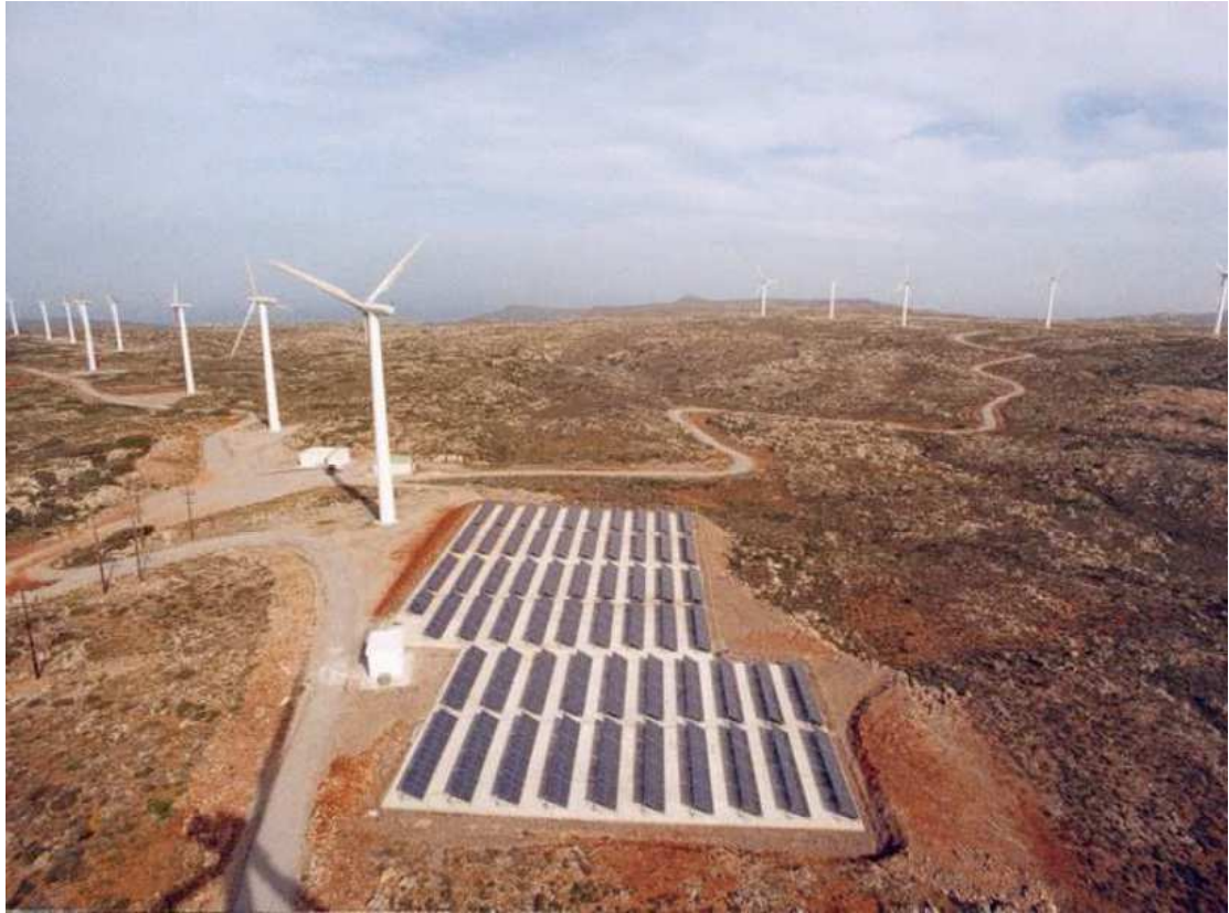
Σχήμα 1 - Μεγάλης κλίμακας εγκατάσταση φωτοβολταϊκών εγκατεστημένη σε άγονη γη πολύ χαμηλής αξίας.
