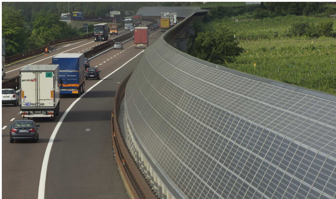
Εικόνα 2 - Μεσαίας κλίμακας εγκατάσταση φωτοβολταϊκών πάνελ που ενεργεί ως φράγμα ήχου αυτοκινητόδρομου. Αυτοκινητόδρομος Brenner, έξω από την πόλη της Marano, Ιταλία.
