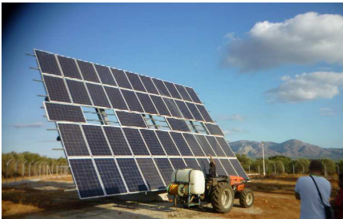
Εικόνα 3 - Καθαρισμός μιας μικρής κλίμακας εγκατάστασης φωτοβολταϊκών με υδροβολή.
