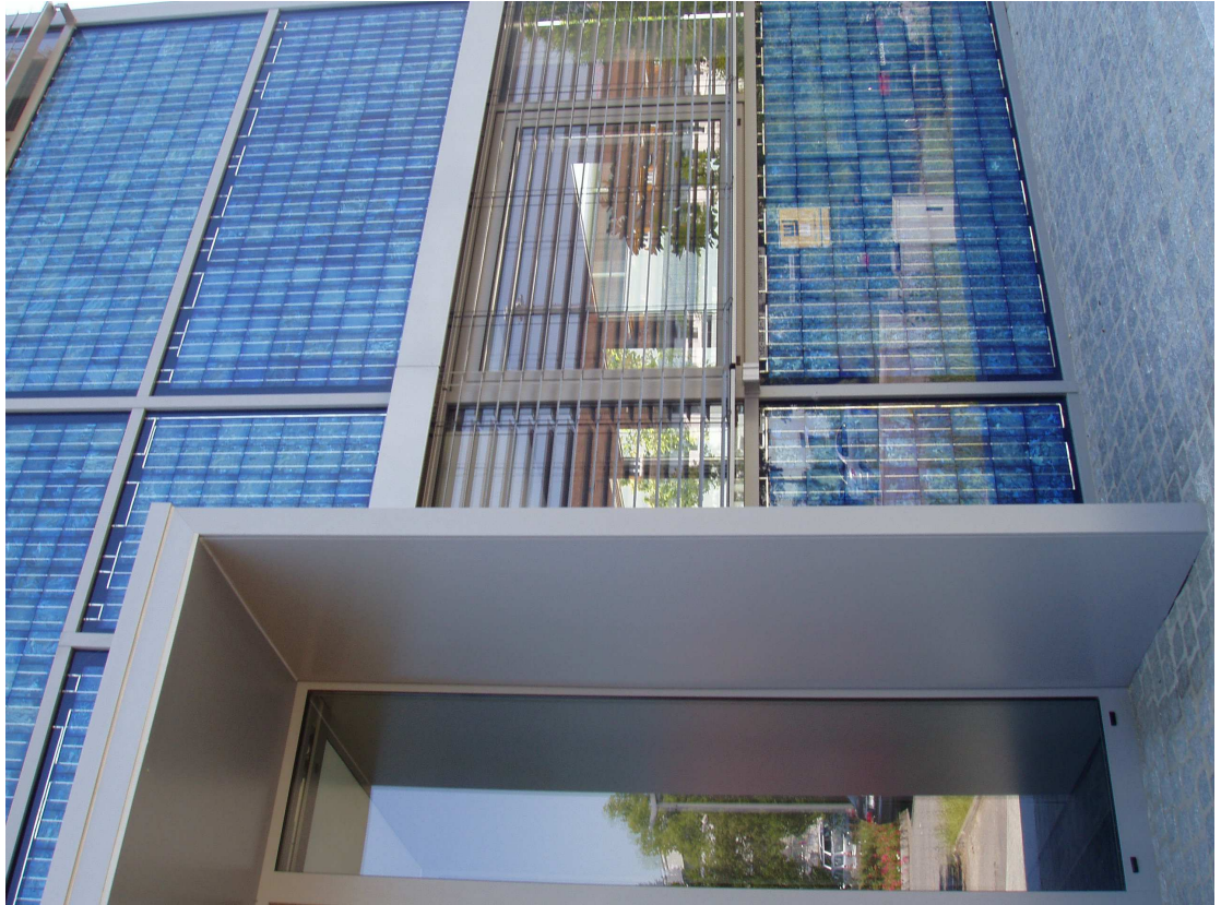
Figure 1 - Πολυκρυσταλλικά φωτοβολταϊκά πάνελ τοποθετούνται εκ των υστέρων να καλύψουν την πρόσοψη ενός εμπορικού κτιρίου. Έχουν χρησιμοποιηθεί για να αντικαταστήσουν καθρέφτες.
